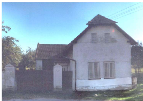
b) č.p. 28 s pilířovou branou
